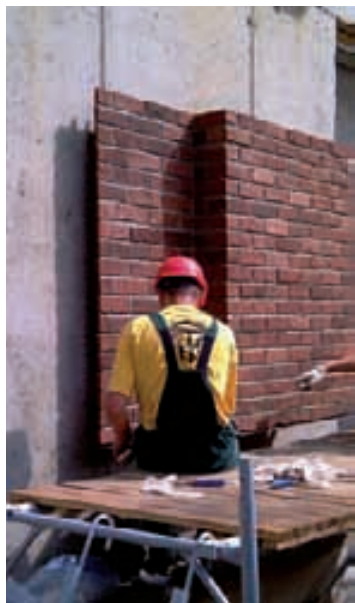
Монтаж навесной вентсистемы «ДИАТ»
