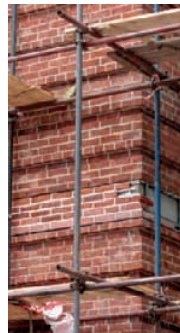
Решение конструктивного элемента «облицовка торца перекрытия»
